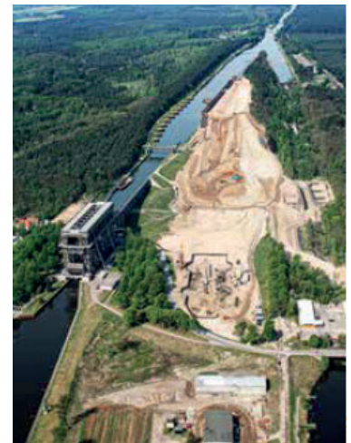
在历史悠久的升船机旁建造基坑。 (© WNA)
