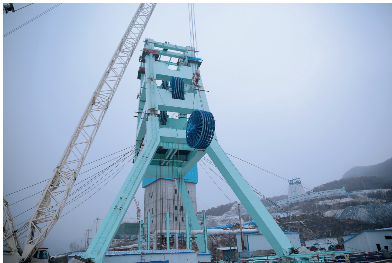
Рис. 1: Монтаж на строительной площадке начался с установки шкивов в копре Сишаньского рудника. Copyright 2022 Tianjin SIEMAG TECBERG.
