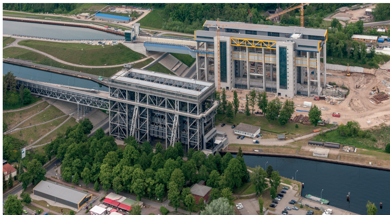
Na pierwszym planie stara podnośnia statków, która przez pewien czas będzie wspierać nową windę w tle - tutaj w fazie budowy. (Photo Copyright Ralf Roletschek / Roletschek.at)
