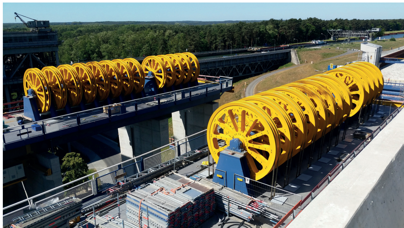
Widok na część ze 112 zainstalowanych podwójnych kół linowych. W tle po lewej stronie stara podnośnia.
