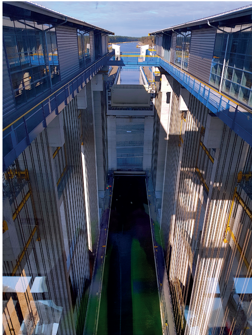
Widok na koryto podnośni z linami stalowymi łączącymi koryto statków i przeciwwagi.
