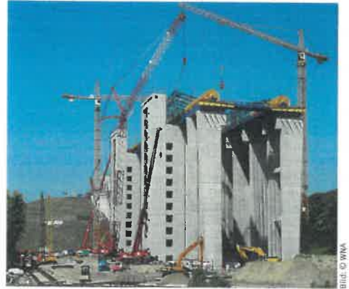
Einhub eines Elements der Seilrollenhalle
