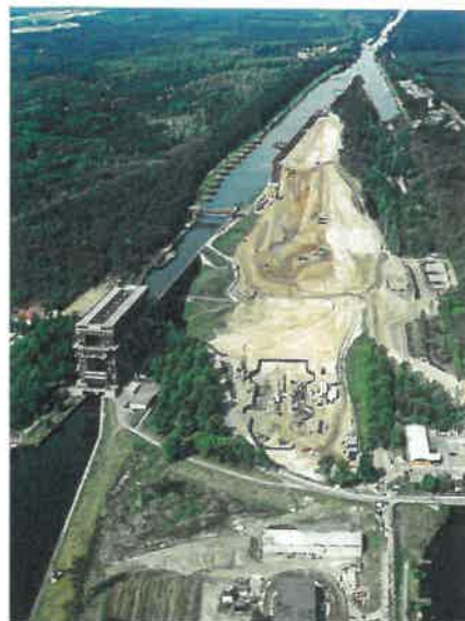
Herstellung der Baugrube neben historischem Hebewerk
